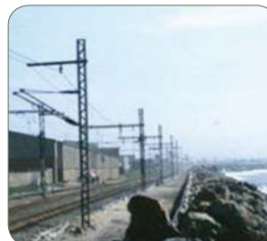
Tipo 1.4003 (primeira aplicação importante em 1982, ao longo da via costeira – 10 m da área de arrebentação, sem corrosão), África do Sul
