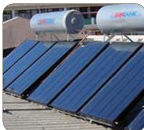
Tipo 1.4509/441 (cilindro), tanque de sol e SASSDA, África do Sul
