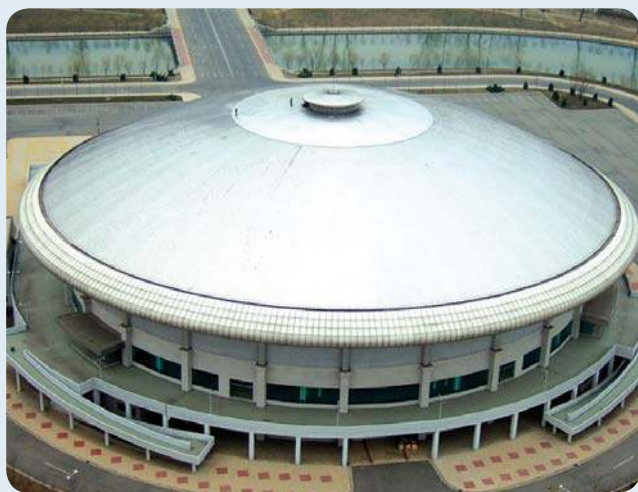
Cobertura do ginásio em aço 445, Coreia do Sul.
