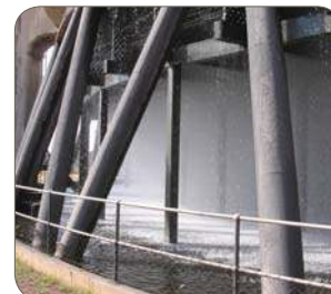
Tipo 1.4003/ 410, envelope da torre de resfriamento em grade em X, África do Sul
