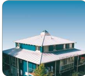
Tipo 1.4510/430Ti (técnica "standing seam"), Ugine & Alz, Alemanha.
