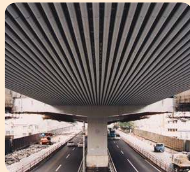
Placa anti-ruídos sob viaduto, Japão.
