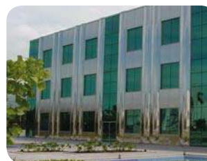
Revestimento parcial em edifício com 444, Brasil.
