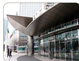
Cobertura em aço inoxidável 444X, na Coreia do Sul
