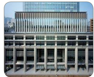
Partes externas SUS445J1, Internas SUS304, Nihonbashi Mitsui Bldg., 2005, Japão
