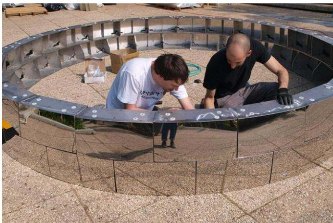
As chapas de aço inoxidável foram cortadas, dobradas e soldadas, produzindo peças no formato de tijolos, permitindo assim a montagem umas sobre as outras, preservando os métodos tradicionais de construção.
