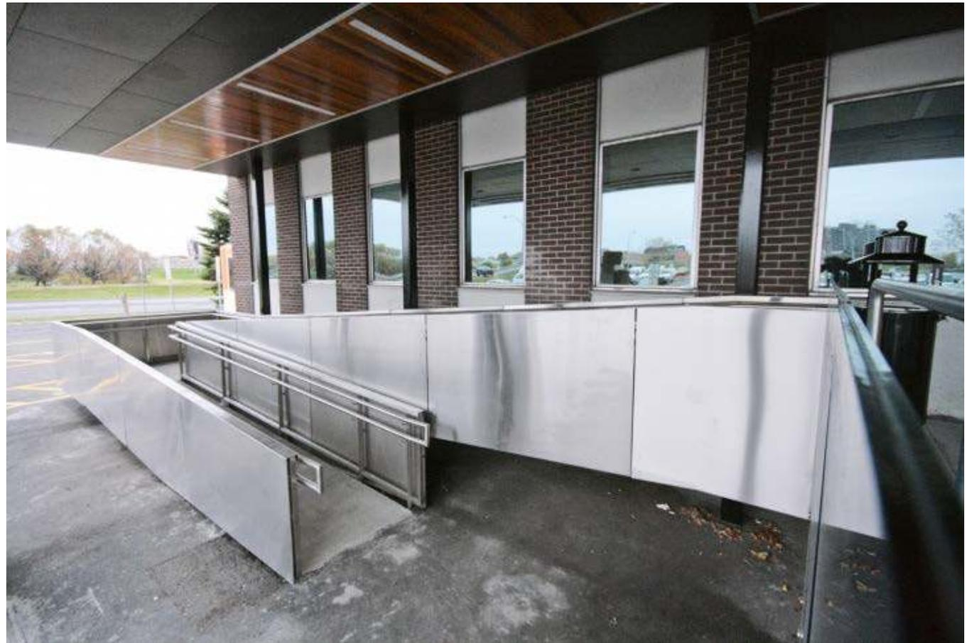
*Aço inoxidável tipo 316 é particularmente resistente à corrosão, sendo também o mais apropriado para ambientes onde o sal para degelo é utilizado no inverno rigoroso e para aplicações próximas ao mar.
