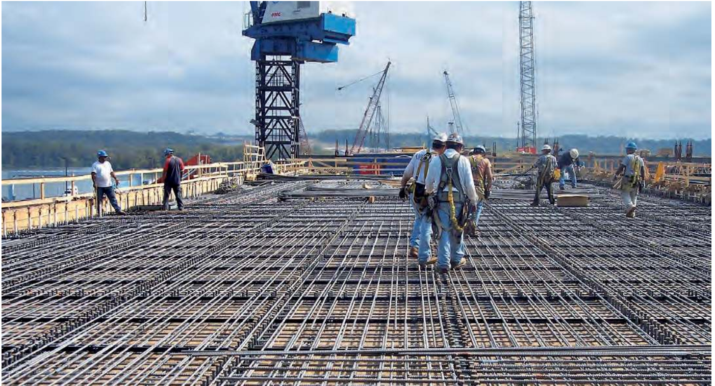
Instalação de vergalhão de aço inoxidável duplex em um amplo deck de ponte. © Hardesty & Hanover, LLP
