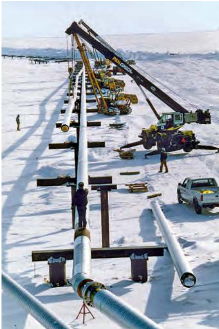
Instalação de tubo de 2205 de 24 pol. isolado sobre elementos de suporte verticais em Prudhoe Bay. © Arco Exploration and Production Technology
