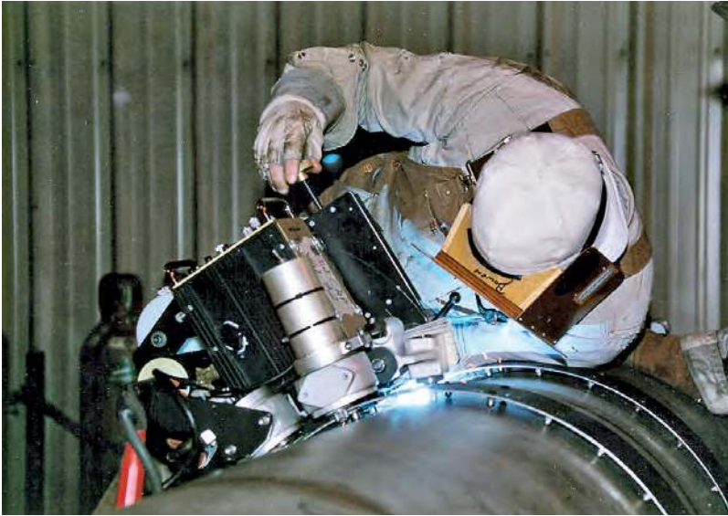
Soldagem automatizada de tubulação em aço inoxidável duplex de grande diâmetro na montanha norte de Alaska. © Arco Exploration and Production Technology
