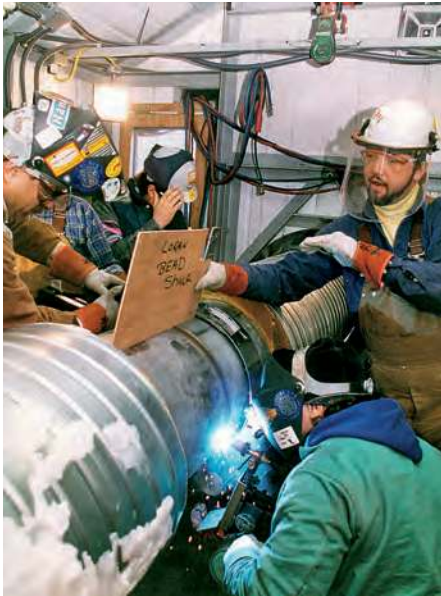
Soldagem mecanizada de uma tubulação de aço inoxidável duplex de grande diâmetro. © Arco Exploration and Production Technology
