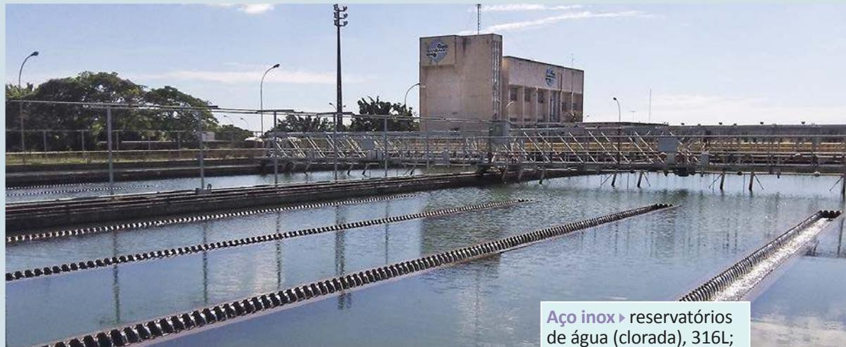
**Aço inox** ▶ reservatórios de água (clorada), 316L; estações de tratamento de água, 304; parafusos, 316L
