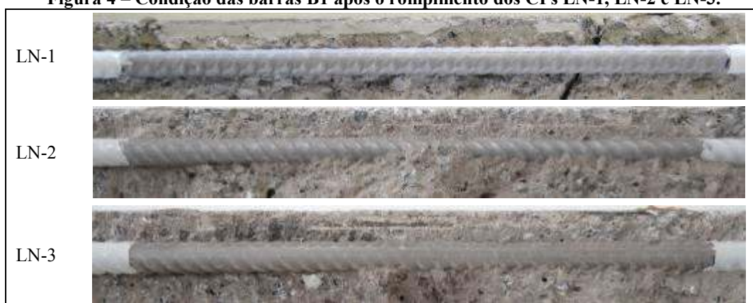
Figura 4 – Condição das barras B1 após o rompimento dos CPs LN-1, LN-2 e LN-3.
